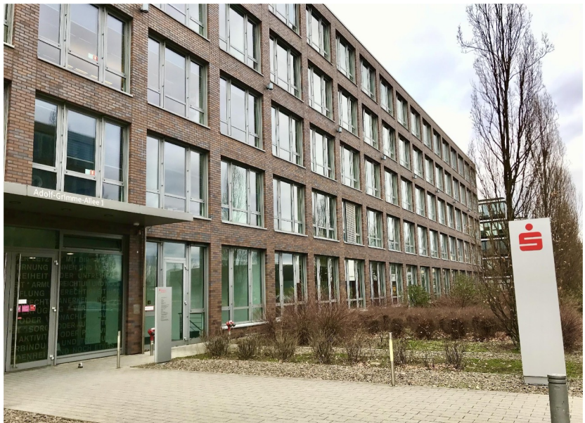
Ehemaliges Dienstleistungszentrum (DLZ) der Sparkasse KölnBonn, Adolf-Grimme-Allee, Köln-Ossendorf
