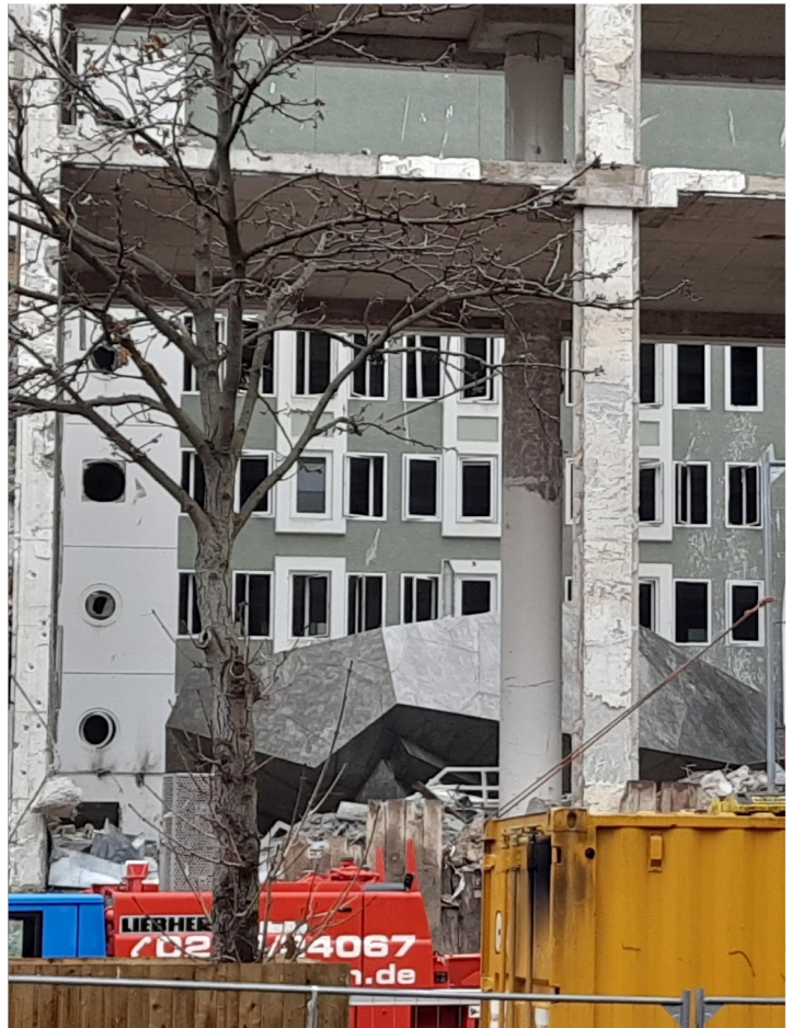
Freigelegter Tresor der Dresdner Bank / Commerzbank an der Königsallee, Düsseldorf
