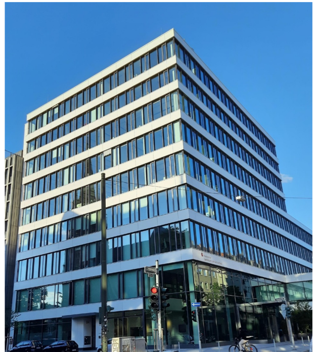
Saniertes Gebäude des RSGV, Düsseldorf
