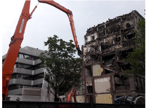
Abriss des WestLB-Gebäudes am Fürstenwall 172 im Jahr 2017
